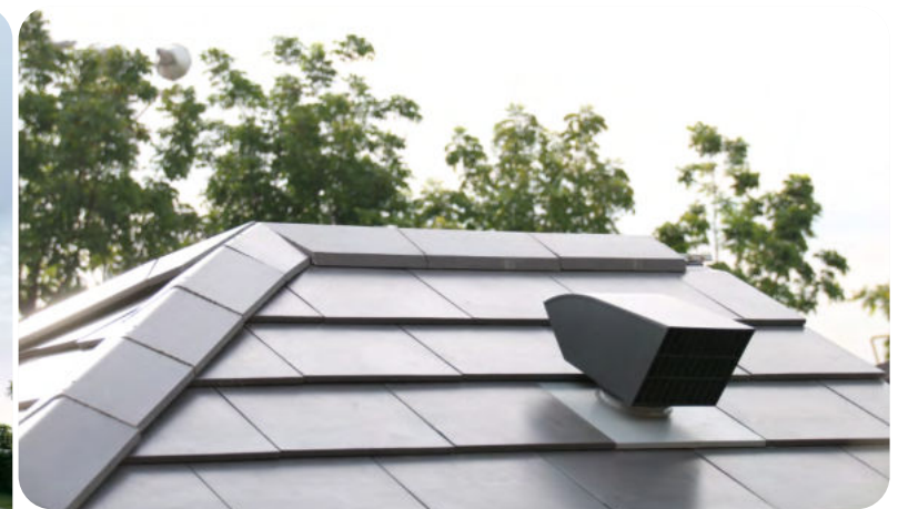
ภาพตัวอย่างระบบ Passive Ventilation ซึ่งระบายความร้อนใต้หลังคาด้วยลมธรรมชาติ โครงการโนเบิล เทเบิล วัชรพล
