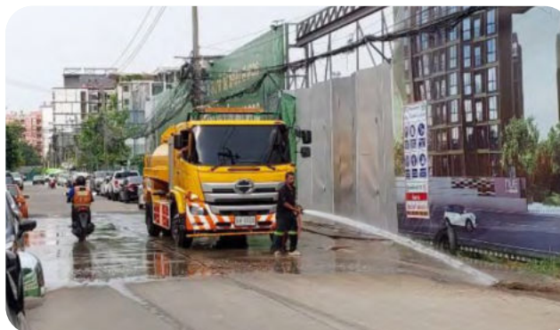
จัดให้มีการทำความสะอาดพื้นที่ก่อสร้างและพื้นที่โดยรอบโครงการเป็นประจำทุกวัน
