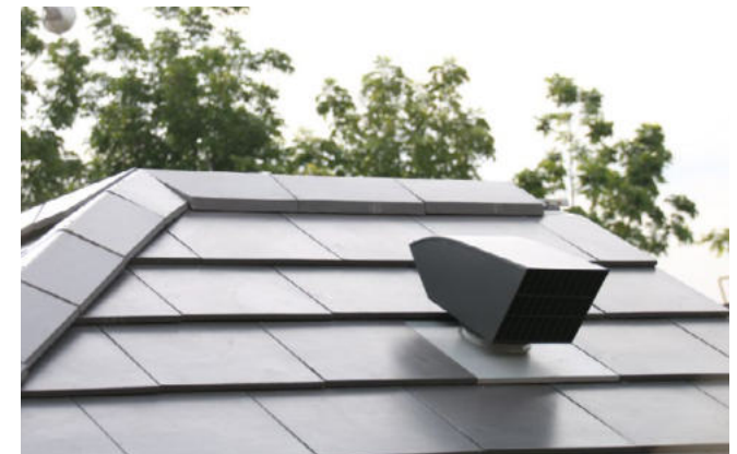
ภาพตัวอย่างระบบ Passive Ventilation ซึ่งระบายความร้อนใต้หลังคาด้วยลมธรรมชาติ โครงการ ไบเบิล เทเบิล วัชรพล
