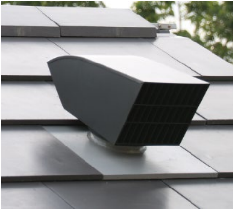
ภาพตัวอย่างระบบ Passive Ventilation ซึ่งระบายความร้อนได้หลังคาด้วยลมธรรมชาติ โครงการ โนเบิล เกเบิล วัชรพล
